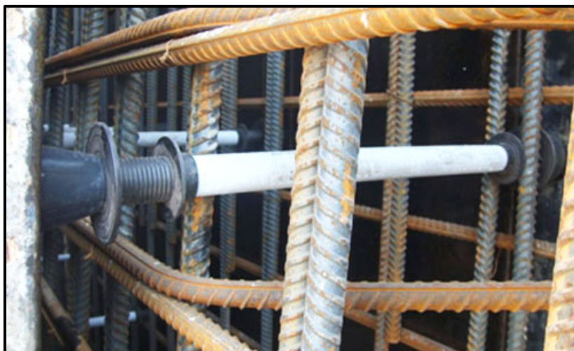
شکل ۶-۴- میان بولت کار گذاشته شده در داخل دیوار بتنی
