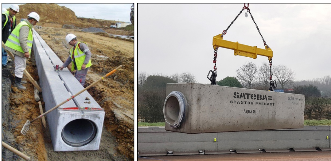
شکل ۵۳: نحوه حمل و نصب کانال پیش‌ساخته خطی
