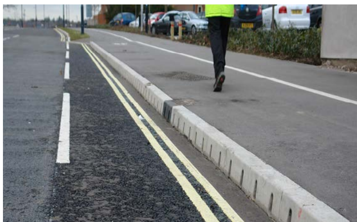
شکل ۳: نمونه‌ای از یک سیستم زهکشی لبه با جدول
