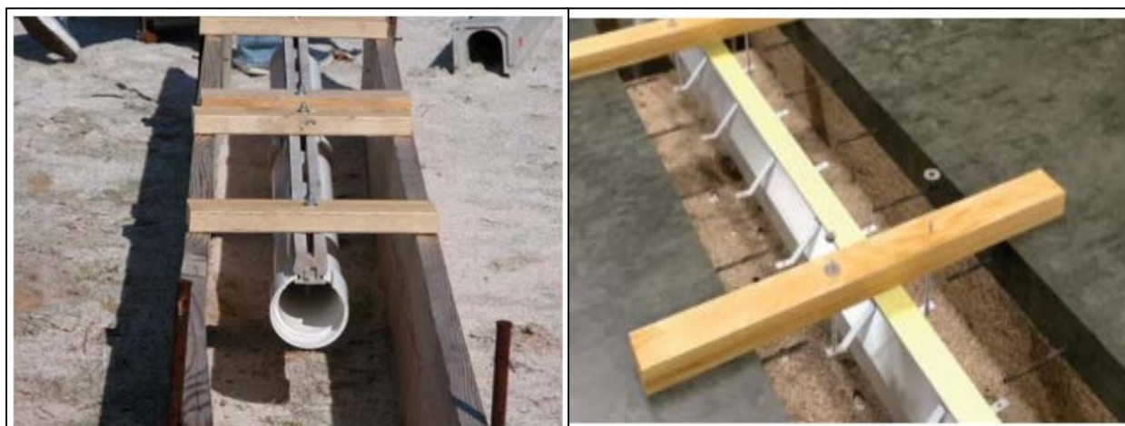
شکل ۵۵: روش مهار زهکش خطی (اسلات) با چوب و بولت قبل از بتن‌ریزی
