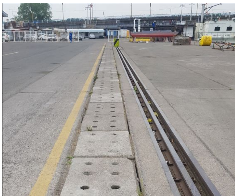
شکل ۷: نمونه‌ای از کانال بتنی سرپوشیده در محوطه ترمینال چند منظوره بندر انزلی
