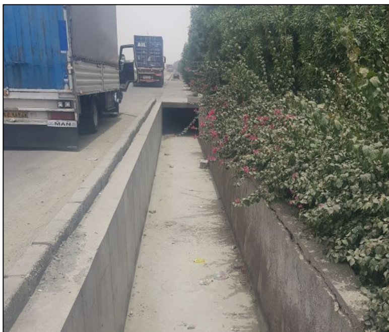
شکل ۶: نمونه‌ای از کانال بتنی روباز در معابر بندر شهید رجایی
