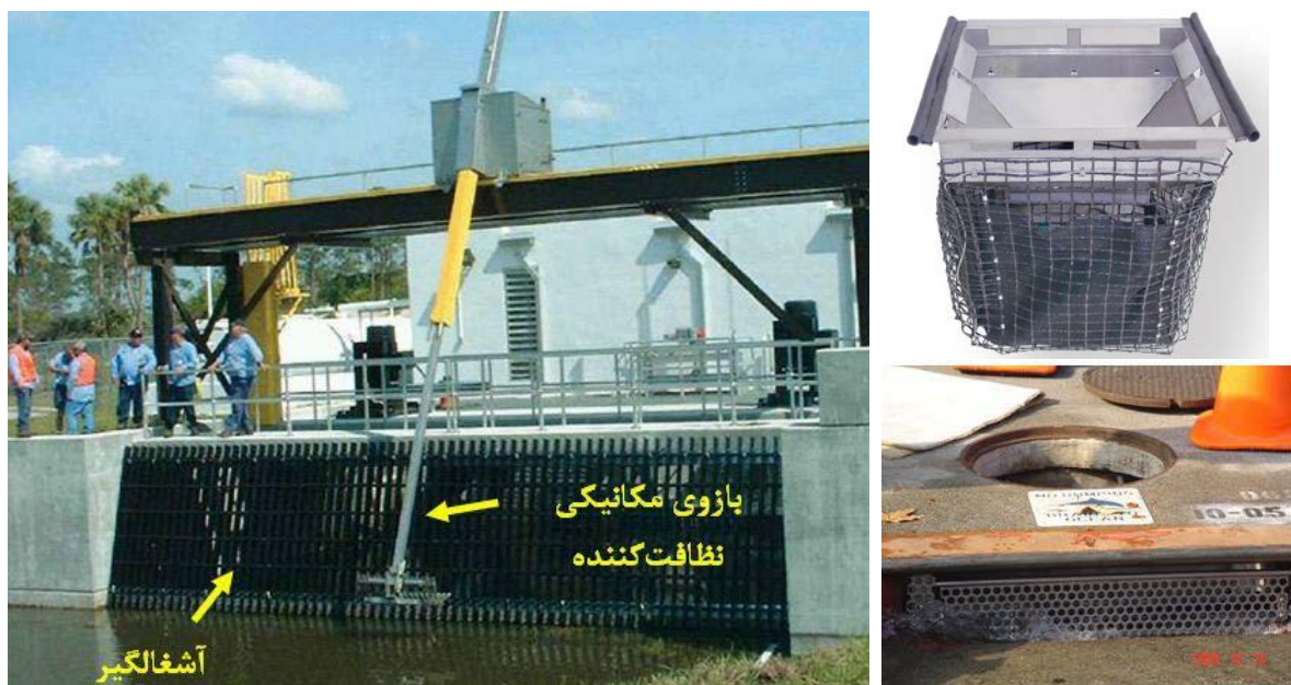
شکل ۲۵: نمونه‌ای از آشغالگیرهای سیستم‌های زهکشی
