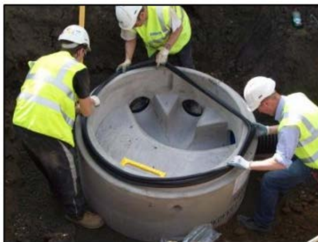
شکل ۵۰: جزییات حلقه بتنی پیش ساخته با واشر لاستیکی
