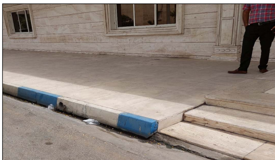
شکل ۱: سیستم زهکشی سطحی با کانپو در محوطه اداری بندر شهید رجایی
