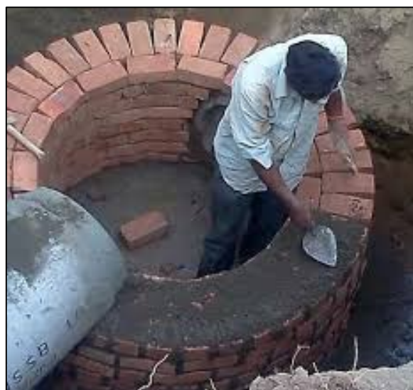
شکل ۵۱: ساخت آدمرو آجری
