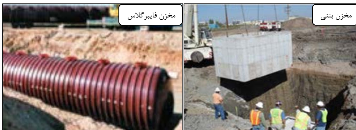
شکل ۹: نمونه‌ای از مخازن زیرسطحی
