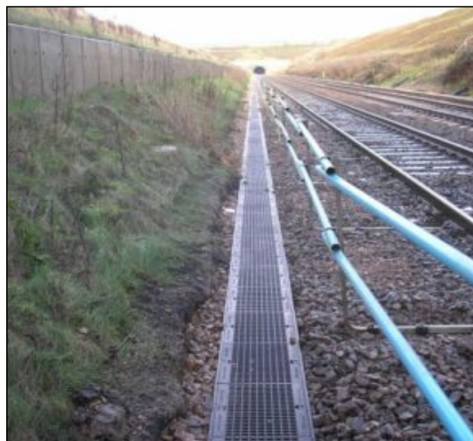
شکل ۱۷: کانال پیش‌ساخته مشبک (trench Drain) در محوطه ریلی
